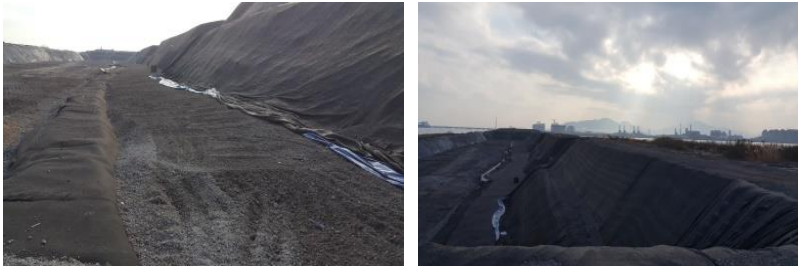
[광양 매립장 복구공사 현장]
